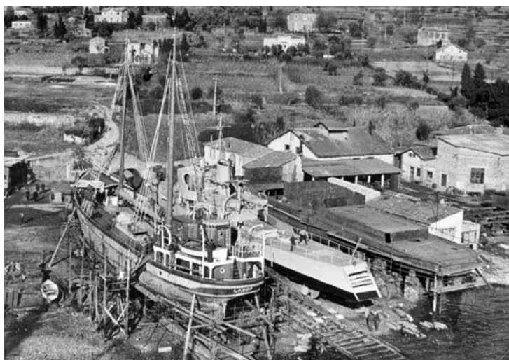
Popravilo in gradnja lesenih ladij v Piranski ladjedelnici (PMSMP)
