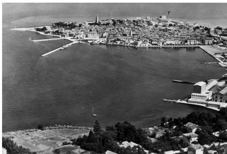
Pogled na Izolo, center ribje predelovalne industrije (PMSMP)
